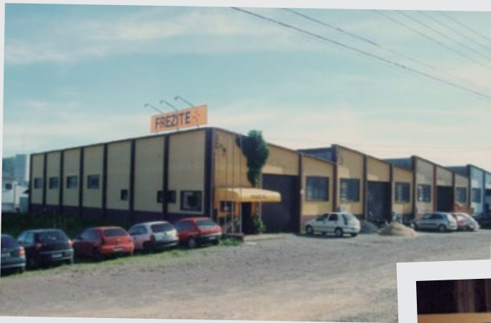
Instalações da Frezite Brasil, em Santa Catarina
